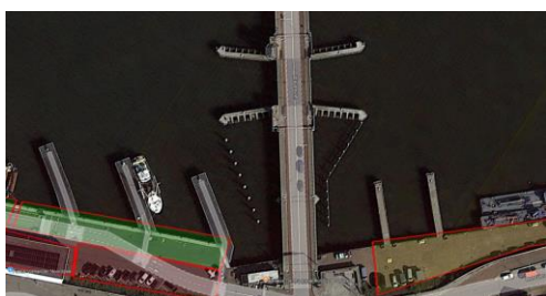
Figuur 3-3: Steigers voor en na de moormanbrug
